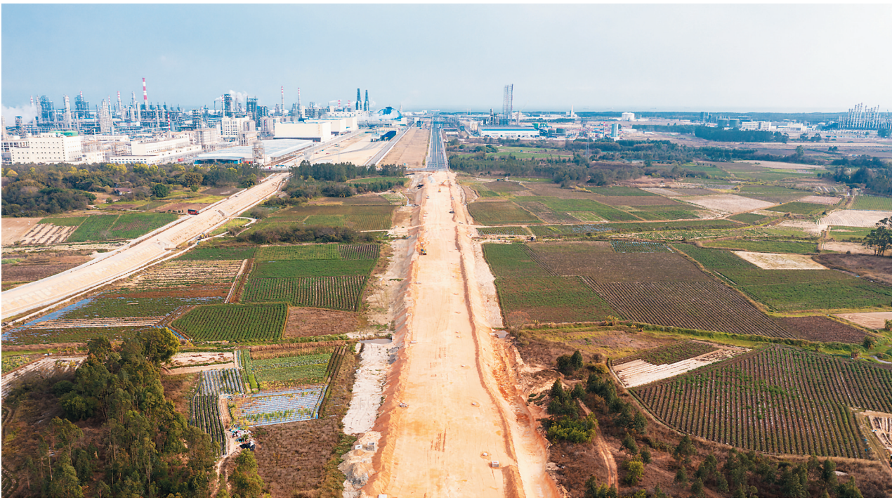
揭阳大南海石化工业区南海大道建设现场，项目路基实现全面贯通。南方日报记者 石磊 通讯员 肖明葵 摄
